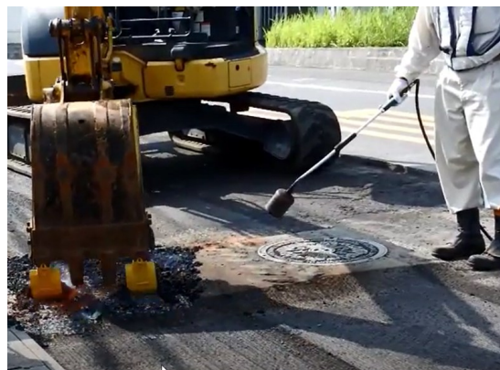
マンホール周りの舗装復旧 ※必ず加熱しながら削り取り作業を行ってください。
